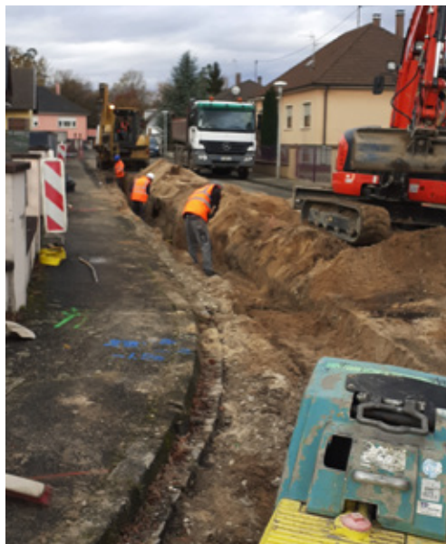
Renforcement du réseau d'eau dans la Rue des Sapins
