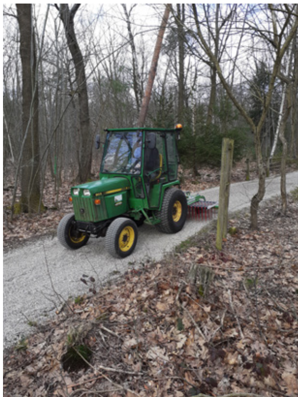
Remise à niveau avec du gravier concassé sur la dernière tranche du parcours de santé
