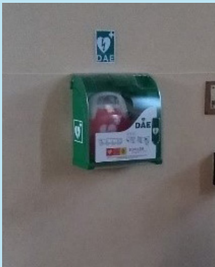
Installation d'un défibrillateur
