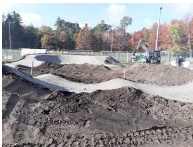
Le pump track lors de sa réalisation
