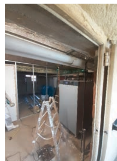
Mise aux normes incendie de la chaufferie de l'école élémentaire
