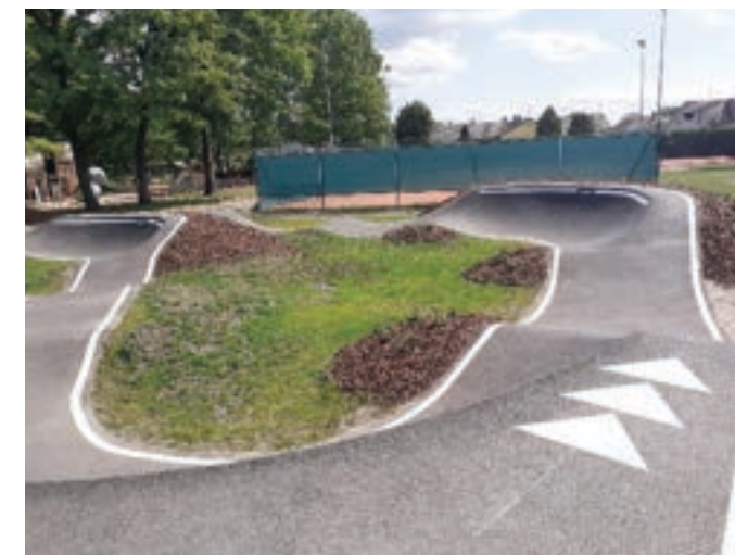
Peinture sur le pump track
