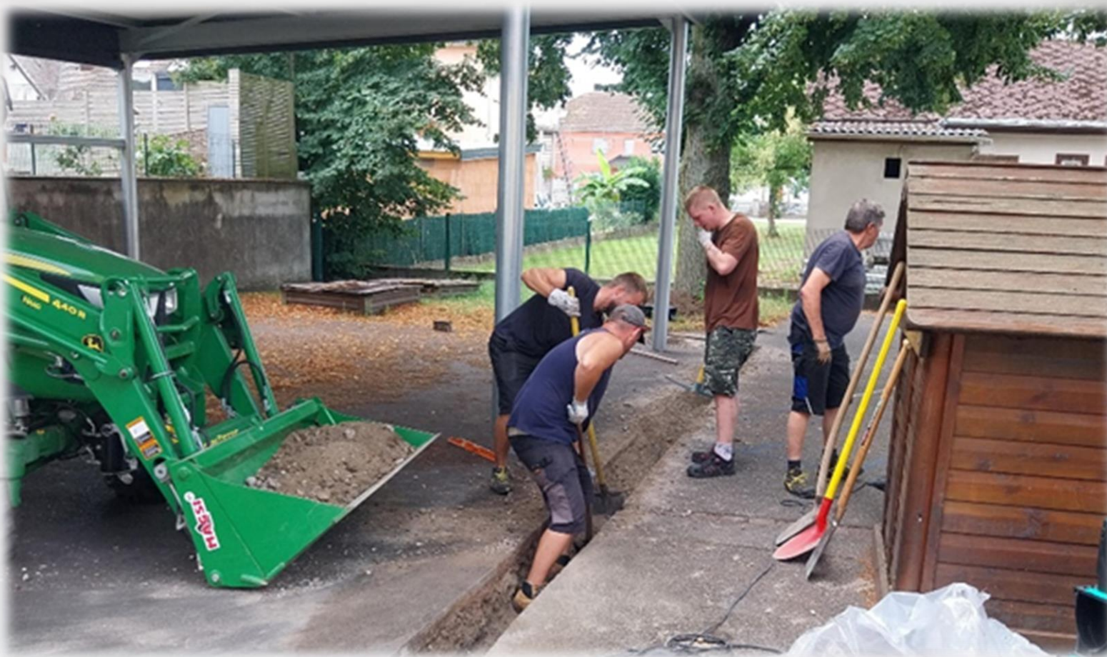
Réalisation d'un caniveau sous le préau à l'école maternelle
