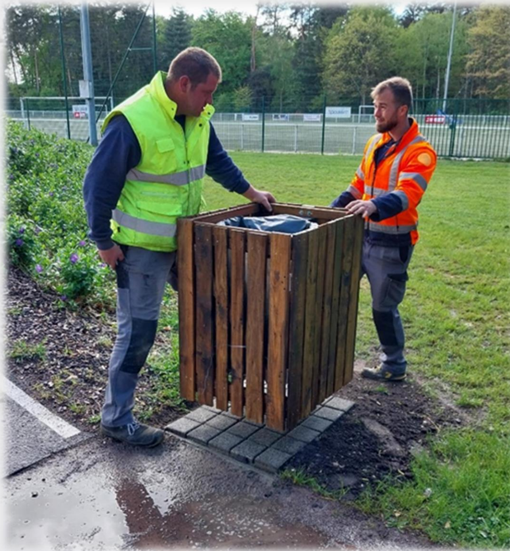
Aménagement de l'aire de jeux avec la pose d'une poubelle réalisée par les agents communaux
